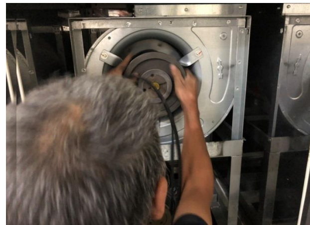
燕巢校區圖資大樓空調箱皮帶調整
