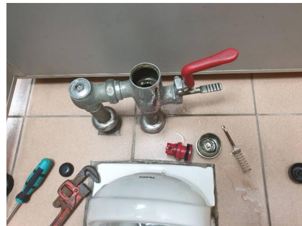
楠梓校區廁所沖水器維修
