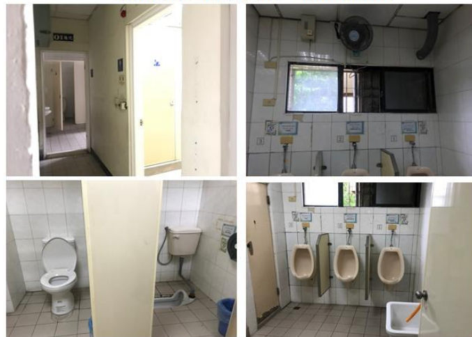
旗津校區行政大樓1F廁所(現況)
