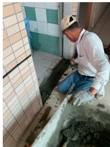
商智院無障礙廁 所斜坡施工
