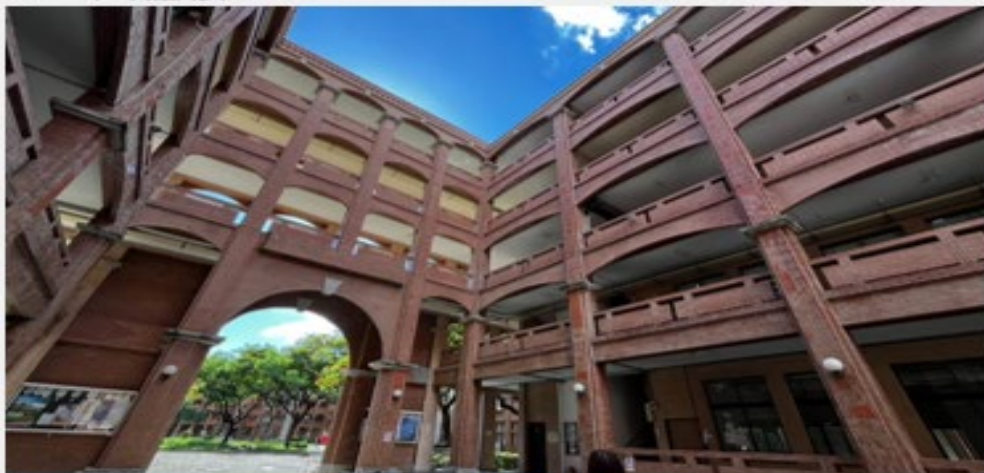
大仁樓現況照片
