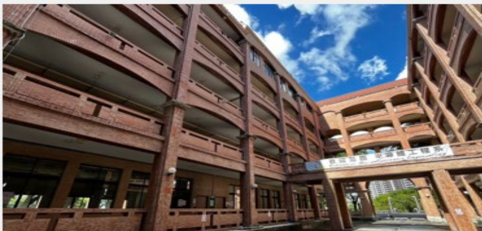
大仁樓現況照片
